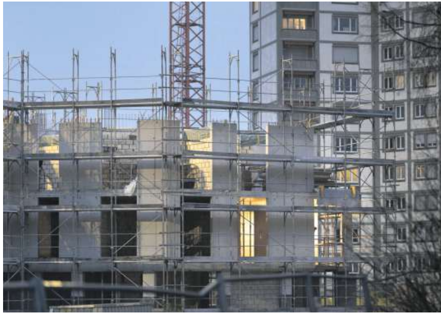
Wohnraum ist notorisch knapp in Zürich, gebaut wird zu wenig.
